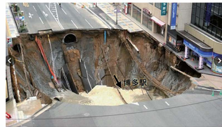
2016年11月8日 博多の道路陥没事故
